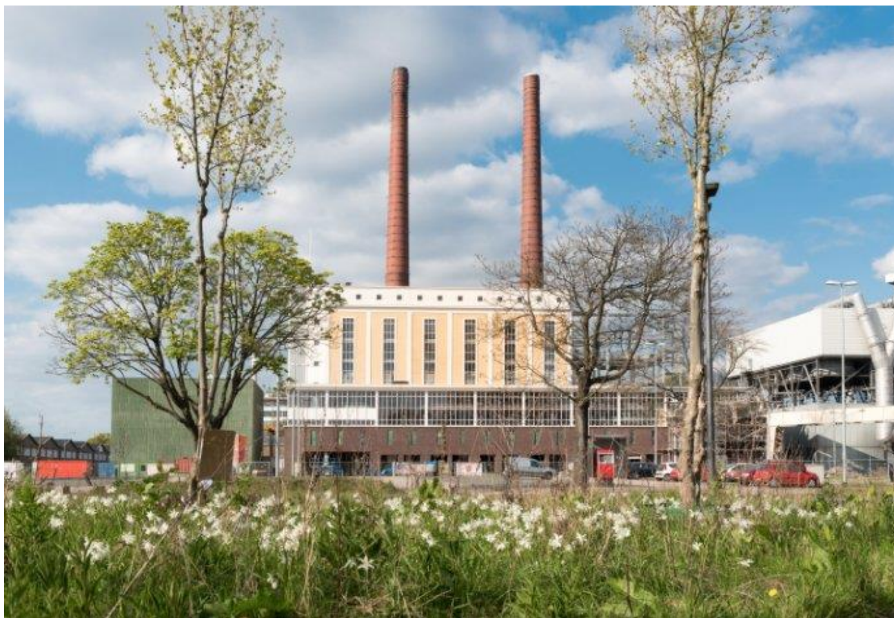
Afbeelding 13: De voormalige energiecentrale uit 1955 biedt sinds 2017 als 'Innovation Powerhouse' onderdak aan creatieve ondernemingen. Rechts is de warmtekrachtcentrale uit de jaren '90 te zien, links de biomassacentrale die in 2016 de energievoorziening daarvan overnam.
