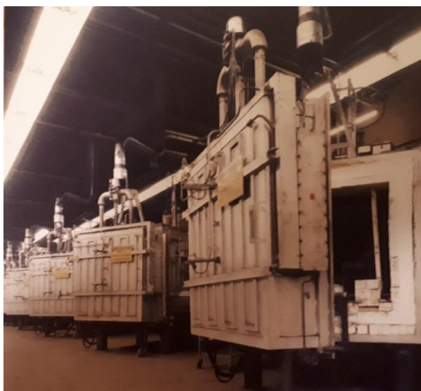
Afbeelding 11: De proeffabriek TY beschikte over een aantal grote kamerovens voor het verhitten van glas.
