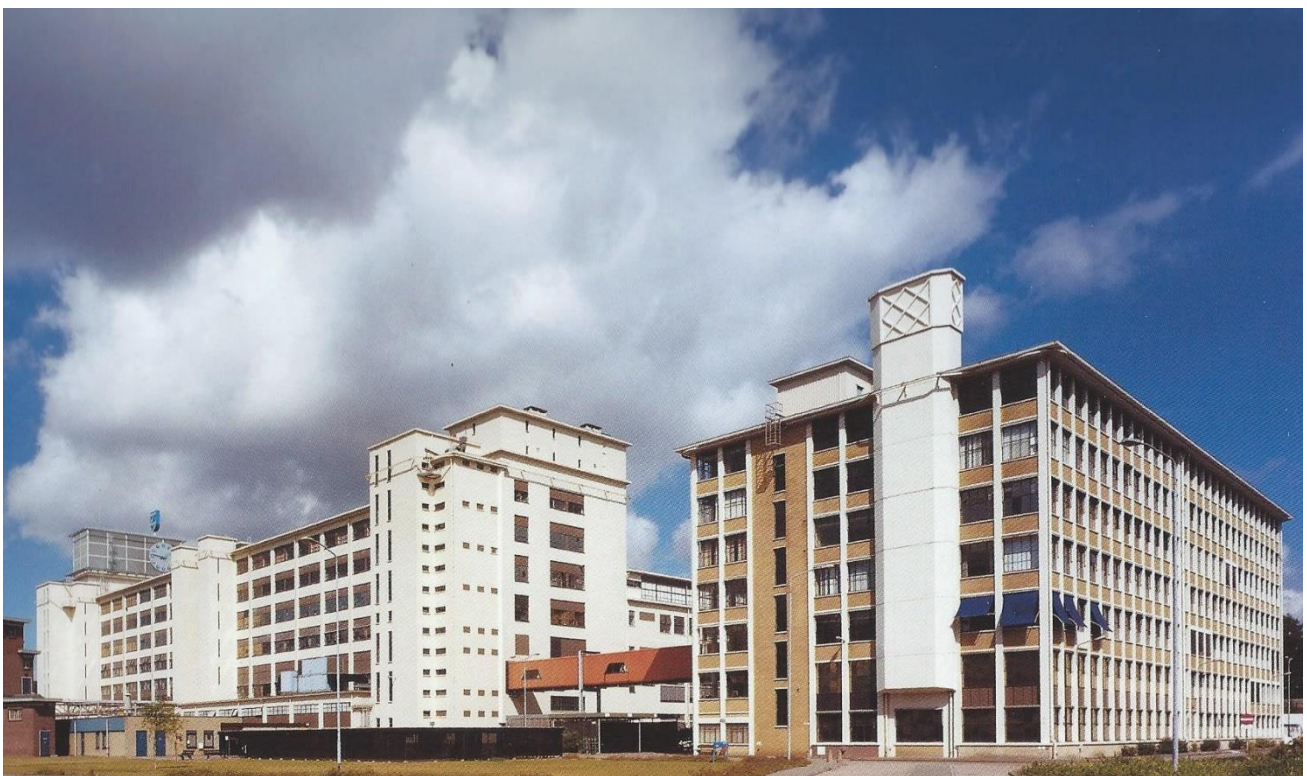
Afbeelding 13: Westaanzicht met links de Philite-fabriek en rechts de Persmassa-fabriek.
