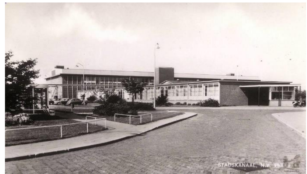
Afbeelding 5: Toegangspoort aan de Electronicaweg.
