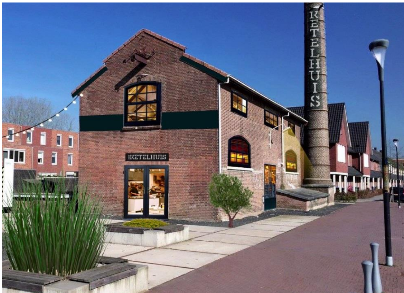
Afbeelding 23: In het ketelhuis van de voormalige Thermionfabriek is sinds 2018 het gelijknamige restaurant gevestigd.
