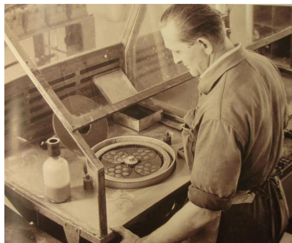
Afbeelding 21: Als laatste stap werden de plakken halfgeleidermateriaal, ook wel 'wafers' genoemd, door polijsten voorzien van een glad oppervlak.
