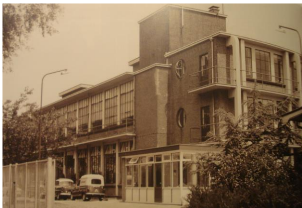
Afbeelding 20: De fabriek na haar uitbreiding in 1951 waarbij een uitwendig betonskelet werd aangebracht dat rechts op de foto zichtbaar is.
