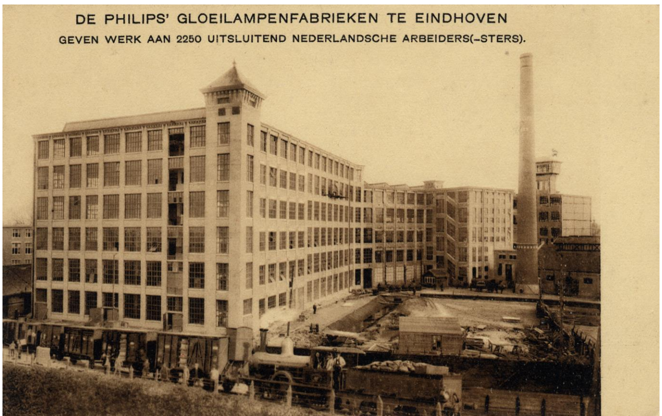
Afbeelding 5: Zicht in zuidelijke richting vanaf de Parallelweg op de betonnen hoogbouw van Beltman uit 1909 (rechts) en 1911 (links), met op de voorgrond de spoorlijn naar Luik (Foto: RHC Eindhoven)
